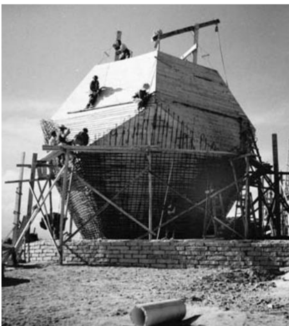
7. Depósito de carbón Instituto de Ciencias de la Construcción Eduardo Torroja (IETcc) Fuente: Archivo Documental ITCCET
