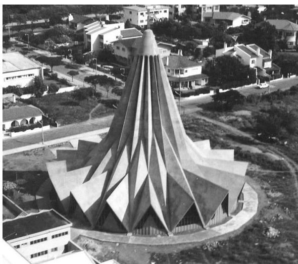
5. Igreja de San Antonio da Polana. Maputo, Mozambique. 1962 Arquitecto Nuno Craveiro Lopes. Foto de Daniel Clements. Patrón de pliegue yoshimura polar Fuente: www.delagoabayworld.wordpress.com Último acceso: 27/08/2015
